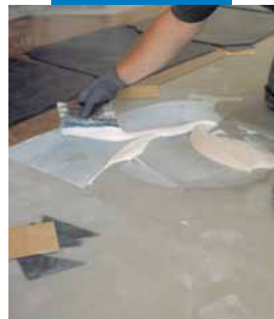
Esempio di posa di PVC (a intarsio) su lisciatura in Ultraplan - CD 2 - Milano - Italia
